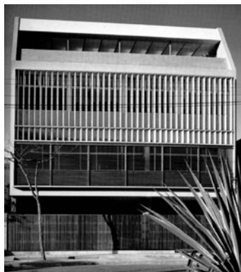
A inclinação do segmento superior alivia o peso da fachada.
